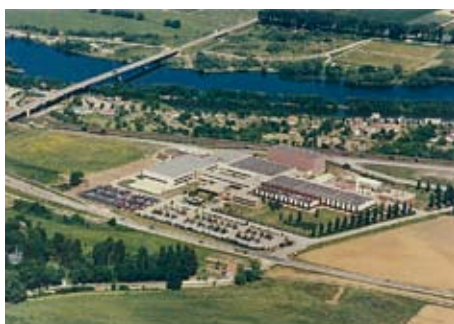
Pont à Mousson (France) est le siège de DR FISCHER Europe S.A.S., le centre de production des halogènes infrarouges, lampes high-voltage et lampes halogènes et incandescentes.
